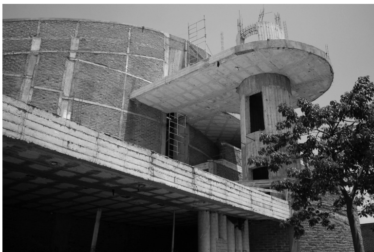
Foto 3 EL TEMPLO EN CONSTRUCCIÓN A SAN TRANQUILINO UBIARCO
